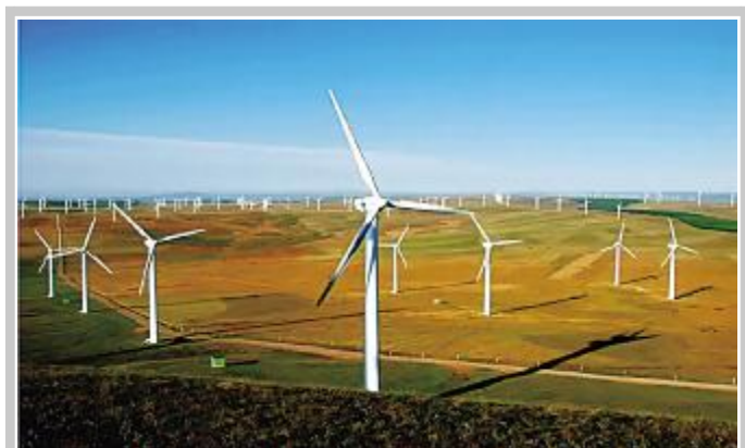
近日,公司中标华能陕西定边50兆瓦风电项目塔筒采购项目,本项目由中国水电四局(酒泉)新能源装备有限公司执行。 装备公司
