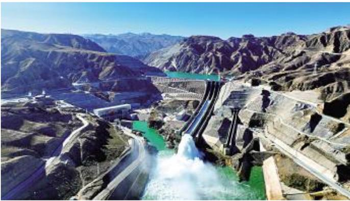
**四局讯(崔佳佳)**12月24日,黄河羊曲水电站最后一台(3号)机组正式并网发电,标志着该电站实现全容量投产发电。公司承担了右岸开挖及引水系统工程、镶嵌混凝土面板堆石坝工程和电站3台单机容量40万千瓦机组安装与调试工作。据悉,2021年12月28日,电站截流成功;2023年12月14日,镶嵌混凝土面板堆石坝填筑到顶;2024年8月14日,导流洞
