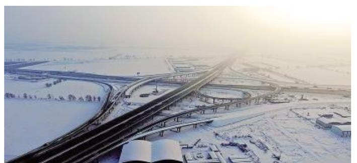
铁路转体桥1座,主线桥为2×65公吨构;设乌奎枢纽互通,其主线桥桥长1100.5米,结构为装配式预应力混凝土连续小箱梁。该工程的建成通车,将增强
