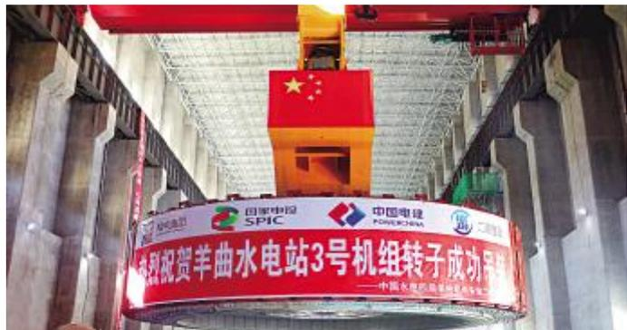
四局讯(李国光 焦小龍 崔佳佳)9月23日,机电安装分局黄河羊曲水电站3号机组转子完成吊装,标志着水电站最后一台机组总装工作取得关键性进展。至此,羊曲水电站三台机组转子全部吊装完成,大件设备吊装任务已临近收尾。
