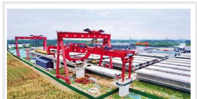
目前,华中公司平漯周高铁项目900吨架桥机顺利完成首孔箱梁架设,漯河示范区制梁场架桥机架梁施工拉开了序幕。
