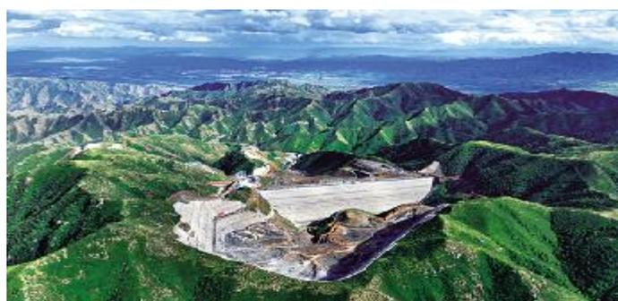
坝顶宽10.0米,坝顶长624.0米,坝轴线处最大坝高115米,总填筑量482万立方米。上水库从2022年6月27日开始浇筑,历时26个月完成大坝填筑,较合同工期提前2个月。
