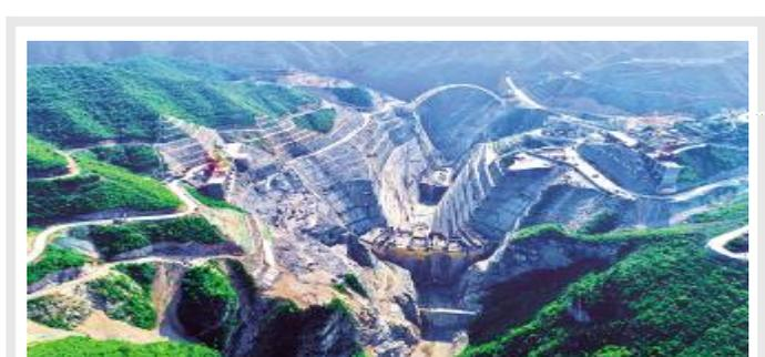
8月底,东庄水利枢纽工程大坝坝体浇筑最高坝段15坝段达到725高程,最低坝段10坝段至710高程,共计完成混凝土浇筑方量104.75万立方米,浇筑工作高速高质量推进中。**高彦 摄**
