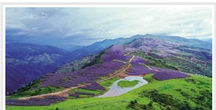
近日,由第三分局承建的毛尔盖水电站水光互补420兆瓦光伏项目部加快推进光伏区安全施工、文明施工和绿色施工,冲刺组件安装、箱变浇筑、逆变器安装、电缆铺设“最后一公里”。李映香 摄
