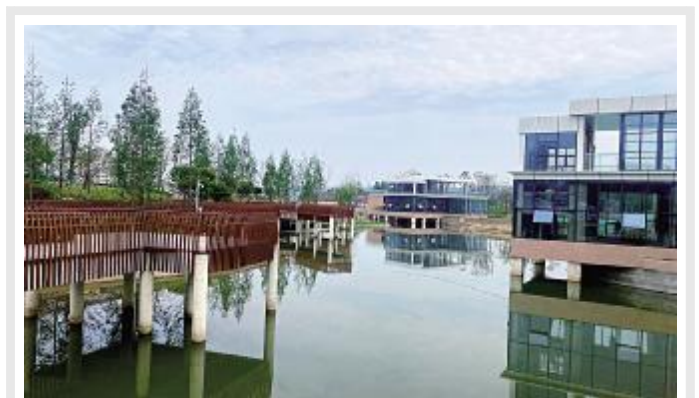
5月30日,随着河东湿地北湖公园景观灯安装完成,标志着安州基础设施等综合建设项目——河东湿地北湖公园顺利完工,为安州区人民又新增一处网红打卡地。
