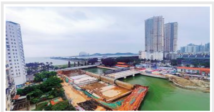
4 月 25 日,随着顶层混凝土浇筑完成,南方公司珠海香洲凤凰排洪渠项目一级水闸重建工程二期工程全面封顶,具备过水条件,比计划工期提前 15 天。 谭嘉仪 摄
