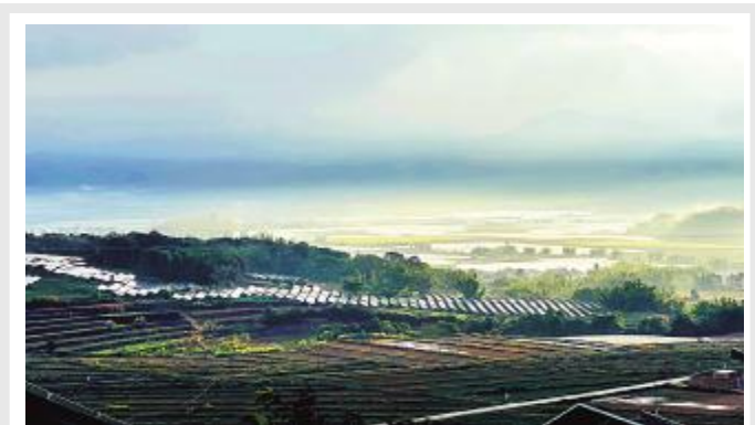
4月8日,由第三分局承建的曼外光伏发电项目最后一个方阵至四号集电线路并网成功,标志着西双版纳州曼外光伏发电项目实现全容量并网发电。
