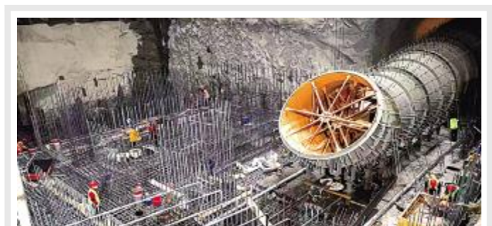
易县抽水蓄能电站工程正式复工。天色微明,地下厂房悉数进场的施工人员已按计划逐步回归机组钢筋安装的有序状态。
