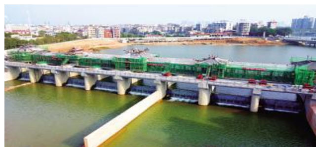
风雨廊桥主体封顶。
