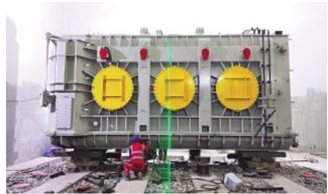
五岳抽水蓄能电站首台主变顺利就位
