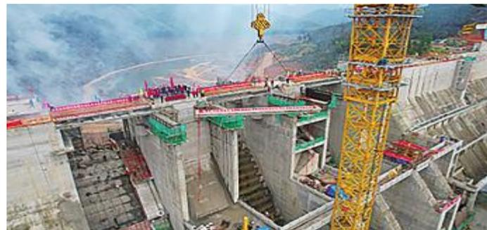
员现场24小时紧盯交通梁浇筑全过程,严格控制混凝土外观质量,牢筑质量防火墙。三是加强安全培训和监督,做好各项安全管理工作。在交通梁吊装期间,项目部既注重保障现场作业人员的安全防护,又时刻监测下方道路交通不受影响,增强全员安
