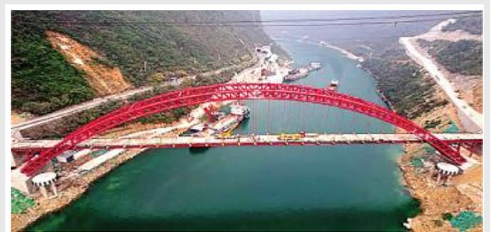
11月23日,重庆白马乌江大桥全桥124块桥面预制板全部铺装完成,开始桥面预制板接缝施工,通车进入“倒计时”。
