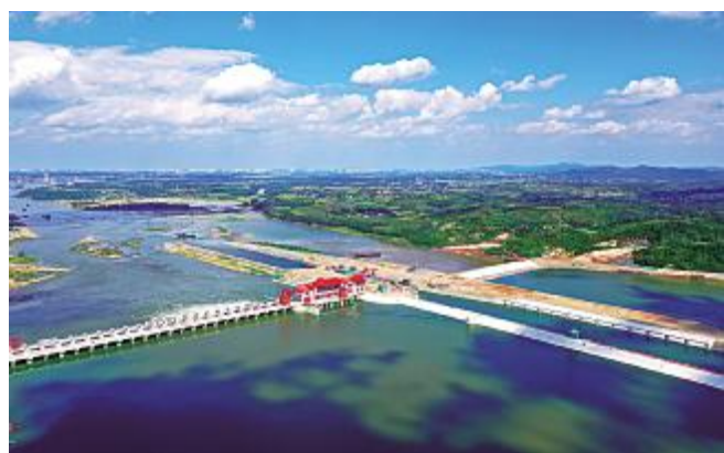
9月26日,由第三分局承建的新集水电站进行了船闸试通航验收及实船试验,标志着新集水电站主体船闸正式具备通航条件,即将正式投入使用。 崔晨天 摄
