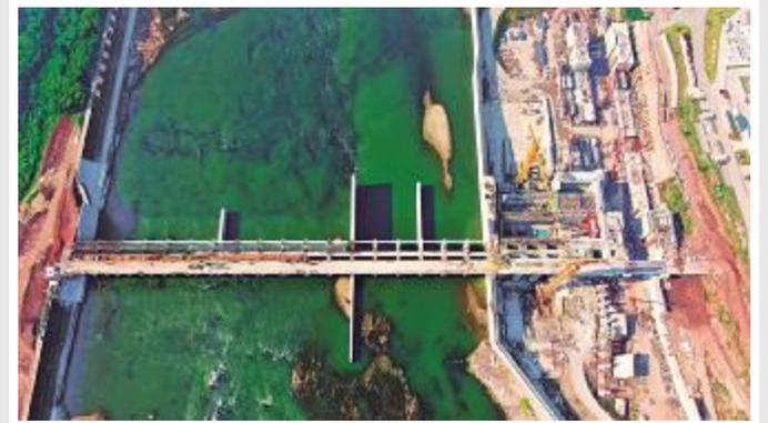
9月2日9时58分,由西南分局承建的重庆双江航电枢纽工程坝顶交通桥完成了冲沙闸坝段6号孔最后一根梁架设,标志着工程左右两岸交通全线贯通。
