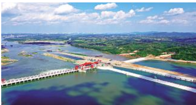
9月15日,公司承建的汉江新集水电站首台机组正式并网发电,标志着新集水电站由建设期转入运营期。 崔晨天 摄
