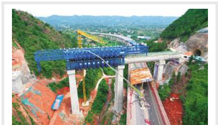
7月7日,向家坝灌区项目部瓦房头渡槽第三跨槽身浇筑顺利完成,为早日实现工程通水目标迈出了重要的一步。
