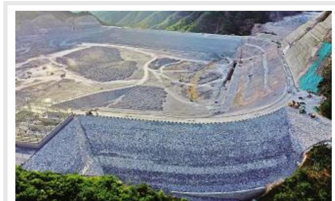
6月7日,随着最后一车堆石料倒入仓面并完成碾压,河北易县抽水蓄能电站上水库堆石坝填筑全部完成。朱宝松 图/文
