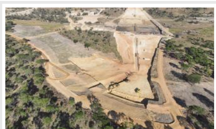
5月23日,安哥拉库内抗旱大坝项目溢流坎段首仓混凝土顺利浇筑,标志着主体结构施工正式拉开序幕。秦泓彬 图/文
