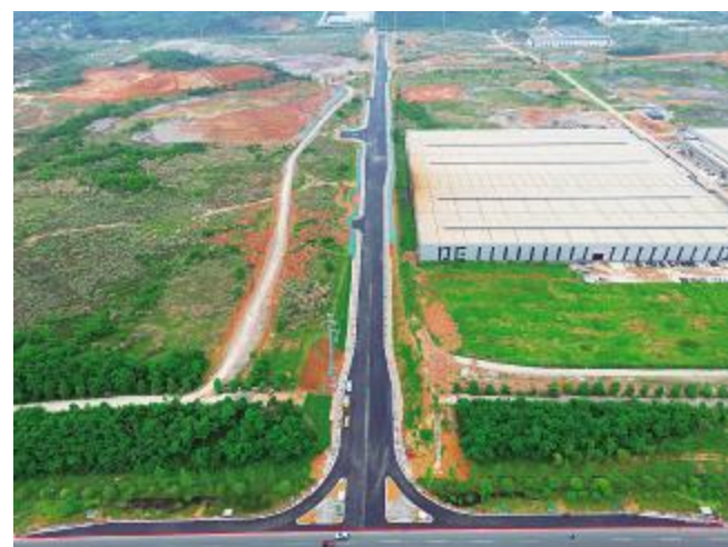
5月9日,由西南分局承建的宜都市“两江一河”区域综合治理PPP项目高新技术园区雨污水处理及市政配套工程高新三路全线贯通,具备通车条件。
