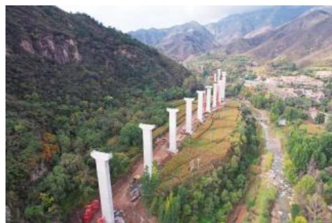
4月24日,随着均才村特大桥最后一根桩基的顺利浇筑,山西阳泉项目钻孔灌注桩浇筑工作全部顺利完成,标志着项目“三隧八桥”关键控制性工程中“八桥”的256根桩基施工全部完成。
